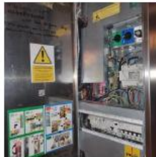
Dispositif de manoeuvre de secours au palier
