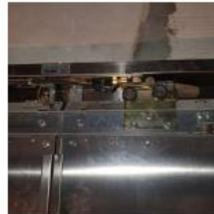
Serrure de porte palière du niveau principal
