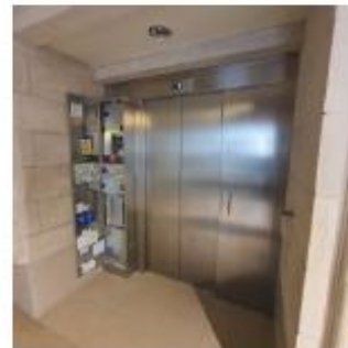
Boite palière avec armoire de commande
